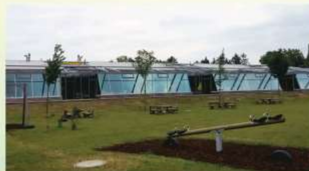
Auf Grund mangelnder Beschattung hat es bis zu 30 Grad in den Gruppenräumen.
